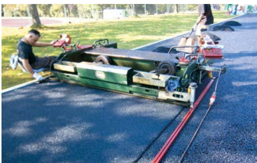
☛ Einbringung des Unterbaus der Hartplätze
