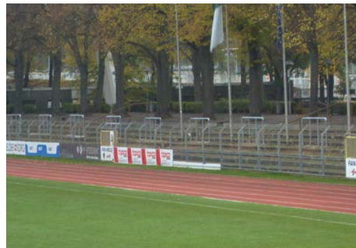
☛ Wellenbrecher im Stehplatzbereich
